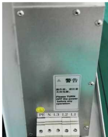
Figura 10-2 Diagrama de Conexão Trifásica de Cinco Fios
