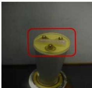
Figura 10-27 – Aplicação de graxa isolante no plugue de alta tensão
